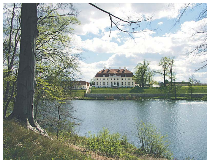
Auch im praktischen Betrieb eine Perle – das Schloss Meseberg mit nagelneuem Trink- und Abwasseranschluss.
