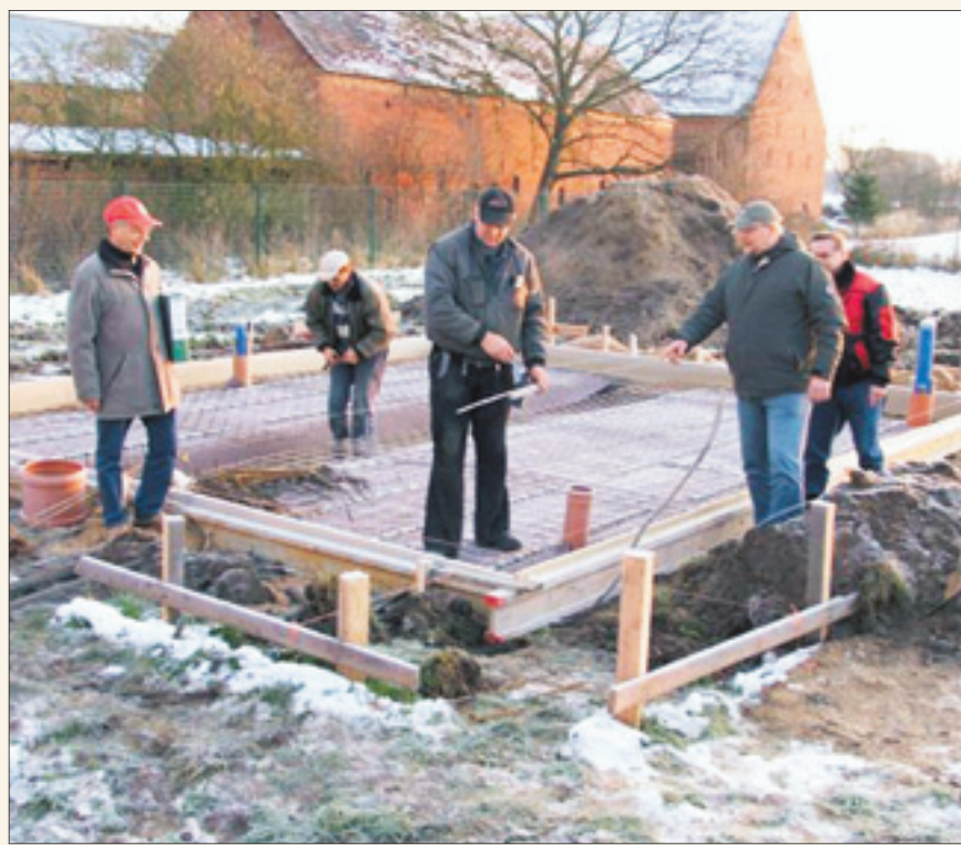
Vorbereitungen zum Fundamentbau für das neue Wasserwerk Banzendorf.
