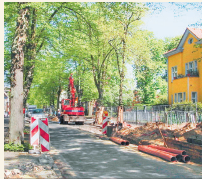
Auch 2009: Erneuerungen der Trink- und Schmutzwasserleitungen in Rheinsberg.
