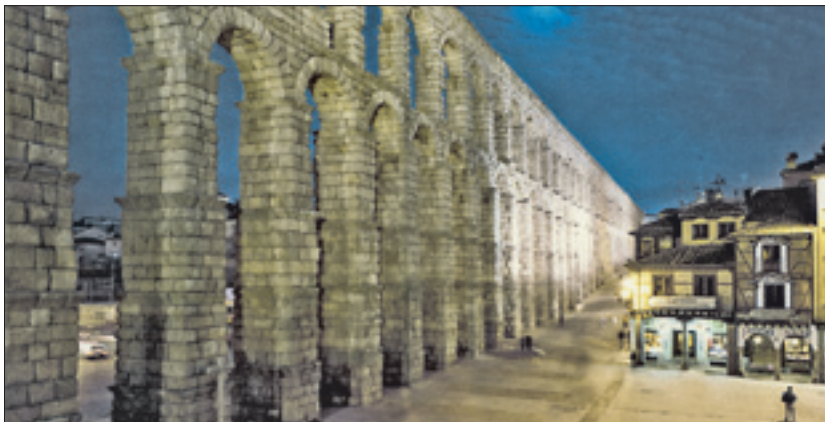
Die 730 m lange Brücke im spanischen Segovia gehörte zu einem 18 km langen Aquädukt, das Wasser in die Stadt brachte. Dieses Meisterwerk römischer Baukunst aus dem 2. Jh. n. Chr. ruht auf 118 Bögen aus Granitsteinen, die ohne Mörtel zusammengefügt wurden.
