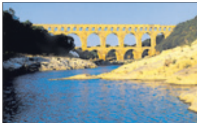
Der zwischen 40 und 60 n. Chr. errichtete 50 m hohe Pont du Gard bei Nimes ist wohl das bekannteste Brückenquädukt der Römer. 40.000 m 3 Wasser wurden hier täglich nach Nimes transportiert.
