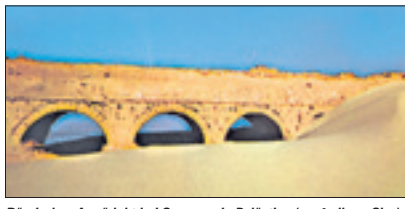
Römischer Aquädukt bei Caesarea in Palästina (ca. 1. Jh. n. Chr.). Die Leitungen bestanden meist aus Stein, wobei auch Holz, Leder und Blei zum Einsatz kamen.
