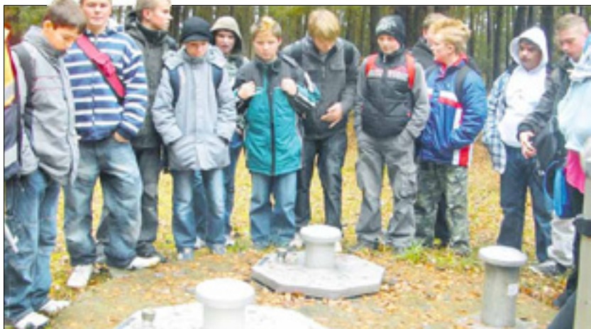
Eine siebente Klasse der Heinrich-Rau-Oberschule in Rheinsberg besichtigt die moderne Brunnenfassung des Wasserwerks Rheinsberg.
