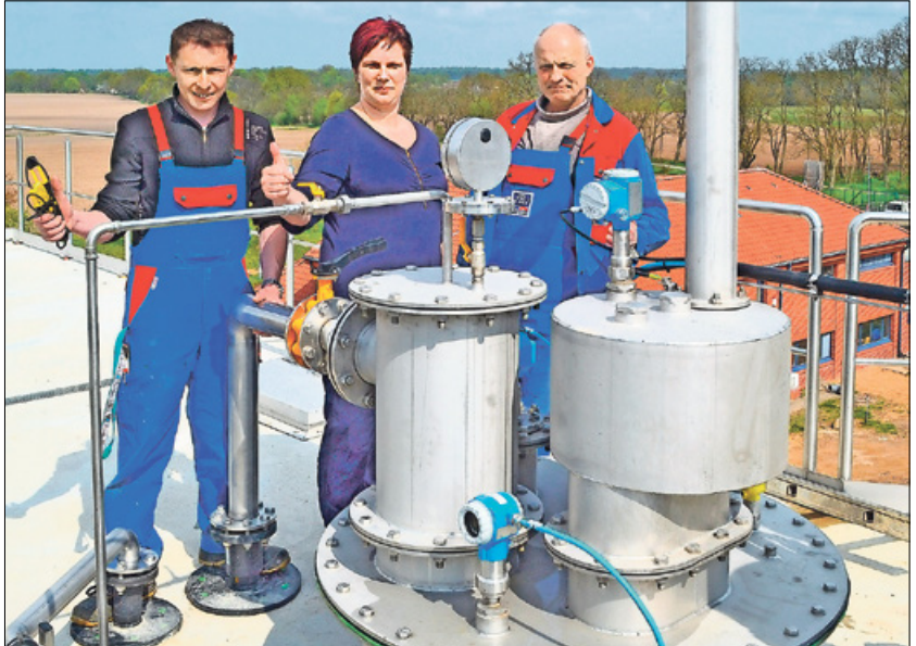
Selbstbewusst nehmen die Mitarbeiter der Kläranlage Mirko Teppner, Heike Schilm und Detlef Priebe (von links) die neuen Bauten in Besitz – hier auf dem Dach des 12 Meter hohen Klärschlammfaulungsbehälters.
