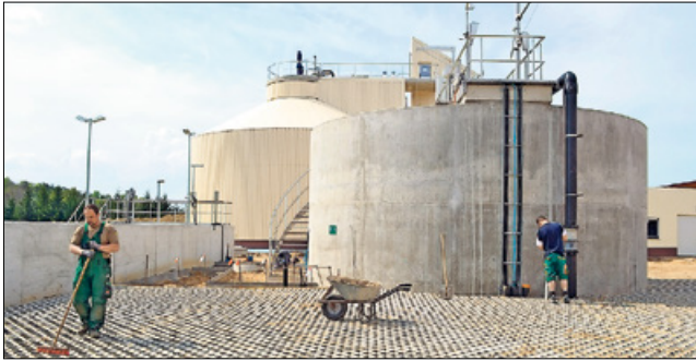
Letzter Schlift auf dem Gelände vor dem Klärschlammfauungsbehälter und dem Vorklärbecken.
