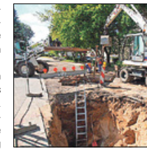
Die Bagger rollen in der Ernst-Thälmann-Straße in Lindow.
