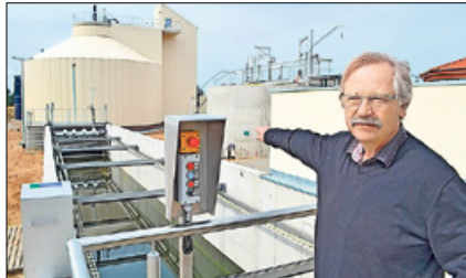
Der technische Leiter Wolfgang Englert zeigt stolz auf die neue Klärschlammfauungsanlage.
