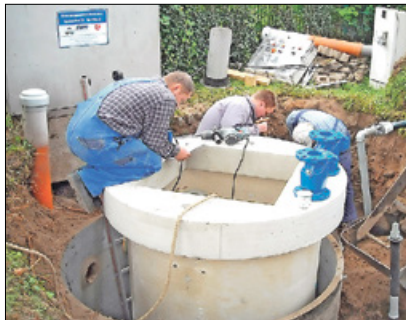
Bauarbeiter setzen die Planungsvorgaben der IWU um.
