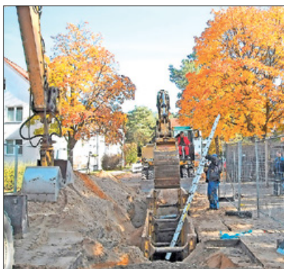
Moderne Leitungssysteme garantieren jetzt auch im Neubaugebiet von Rheinsberg eine optimale Ver- und Entsorgung.
