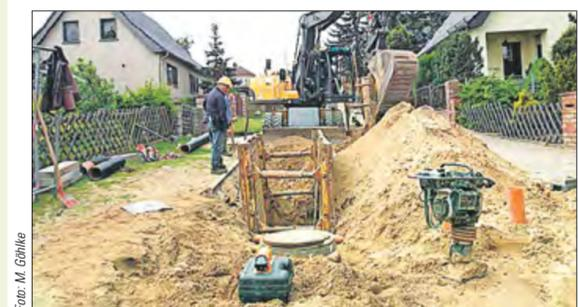
370 Meter Schmutzwasserleitung, 399 Meter Trinkwasserleitung sowie 373 Meter Regenwasserleitung werden im Granseer Gartenweg verlegt.
