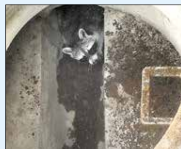
Tierische Begegnung – ein Waschbär hat sich in die Kanalisation verirrt.
