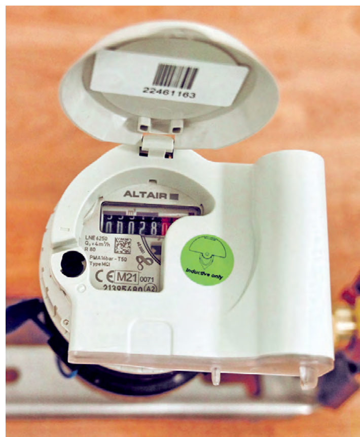
Zählerstandübermittlung ohne abzulesen: ein mit Funkmodul ausgestatteter Wasserzähler.
